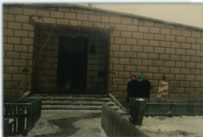
Płonie budynek starej szkoły. Jest rok 1997.
